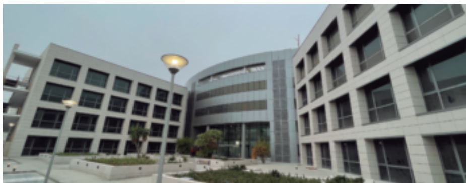
Rehabilitación de oficinas en el Edificio Galia, en Málaga.
